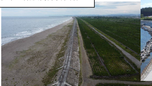
仙台市：荒浜海岸防災林
