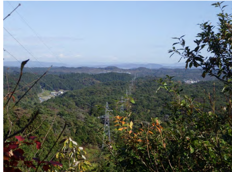
高圧線配置状況
