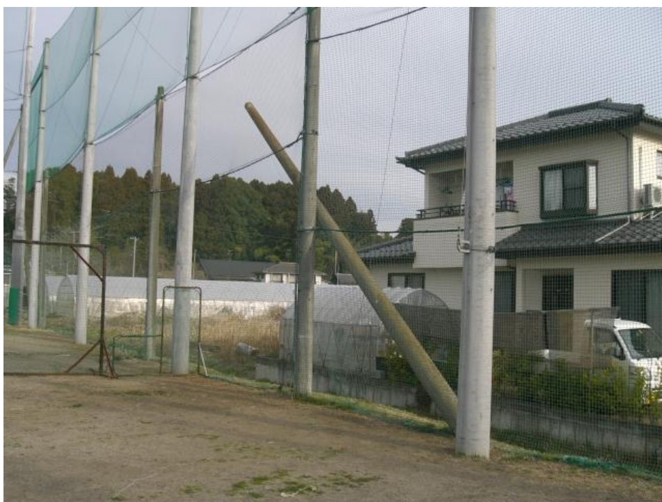
野球グラウンド防球ネット柱の傾斜
