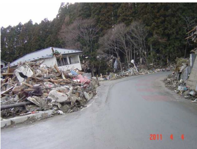
下側より職員宿舎付近の撮影
