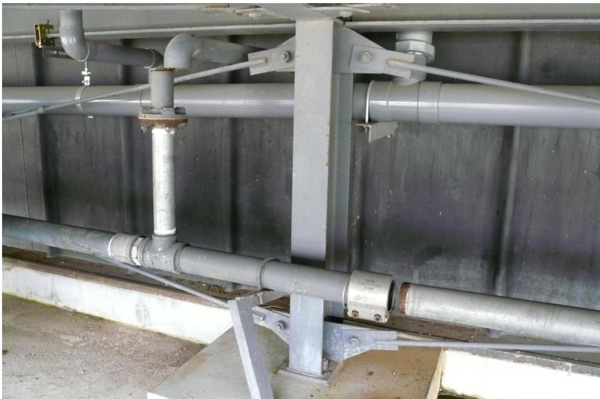
(写真6) プール水循環配管破損部②
