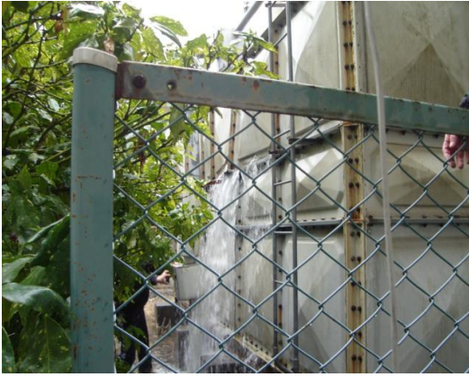
震災直後 受水槽の側面破損により水が流出
