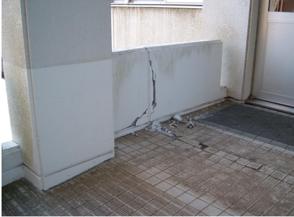
3階渡り廊下棟
