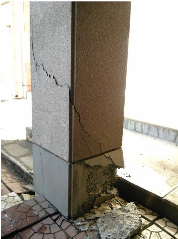
1階ピロティ柱脚
