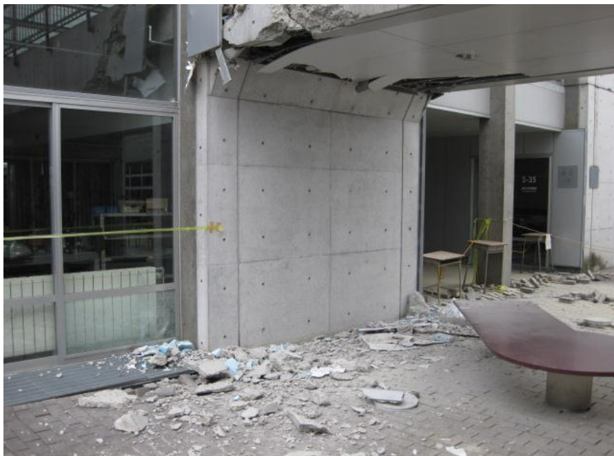
RC渡り廊下破損
