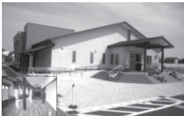
▲県産材を使用した木造公共施設
