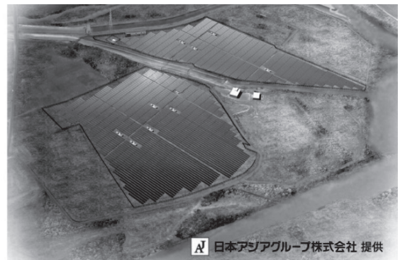
▲宮城県農業高等学校跡地におけるメガソーラー建設イメージ
