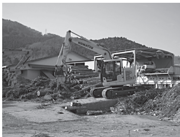
▲ 搬出された木質バイオマス
