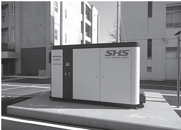
▲ スマート水素ステーション
