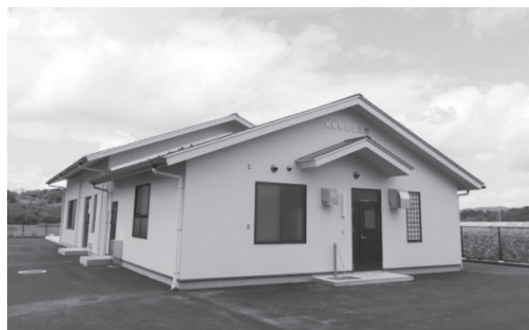
▲大泉地区汚水処理施設（登米市）
