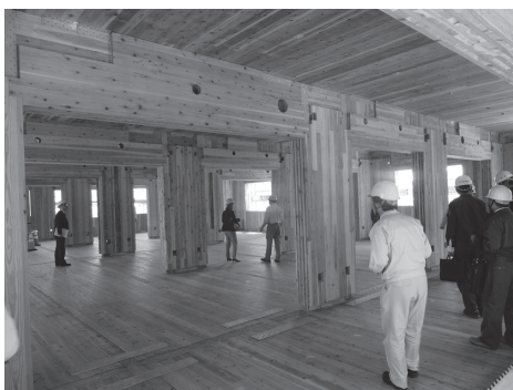
▲県内初の3階建てCLTパネル工法建築
