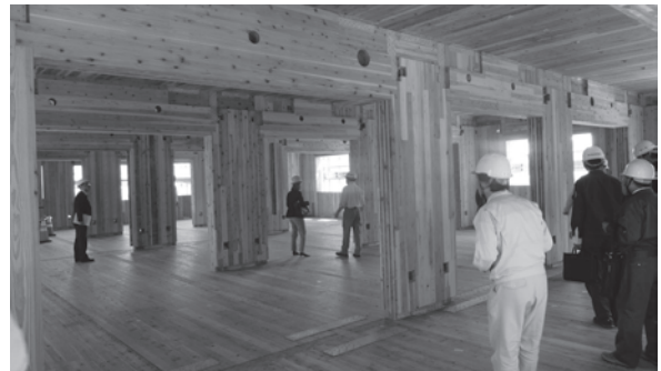
▲県内初の3階建てCLTパネル工法建築
