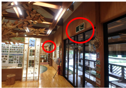
特記事項 誘導灯の点灯(照度など)状況を
