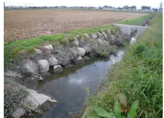
生きものに配慮して整備された水路の石積み護岸
