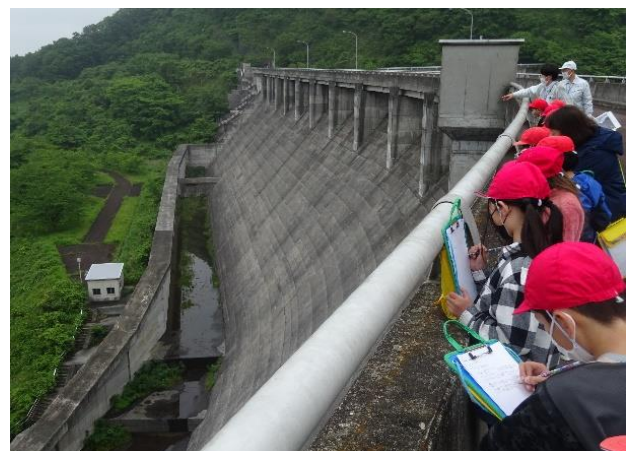
南川ダム（松島第二小学校）
