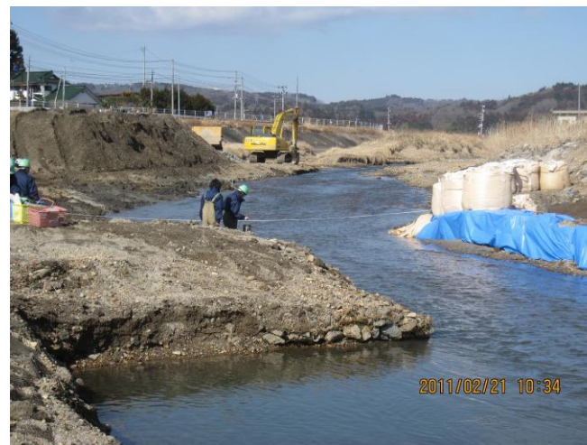
バイオモニタリング調査状況写真（H23.2.21）
