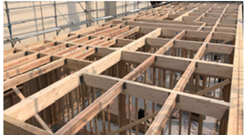
ユニオンフレーム工法(ウイング社)
