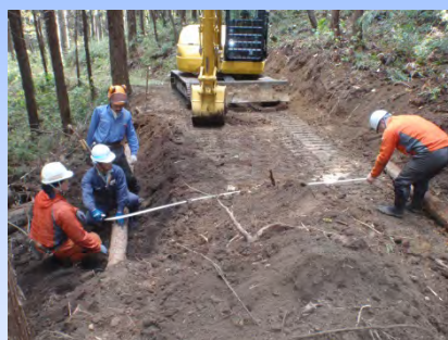
作設実習（丸太組工法）の様子
