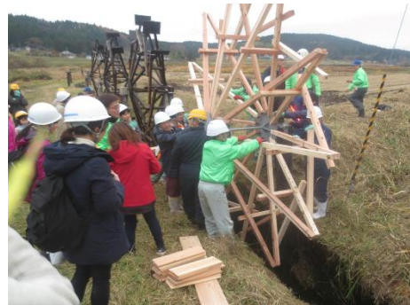
写真 13 地元スギ材による水車を設置
