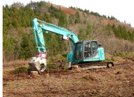
写真 12 フェラーバンチャによる地拵え作業
