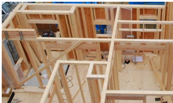
写真1：建築中のツーバイフォー住宅
