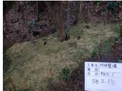
【竹パウダーの敷設状況】
