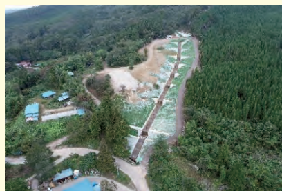
治山事業による復旧状況(山腹工)
