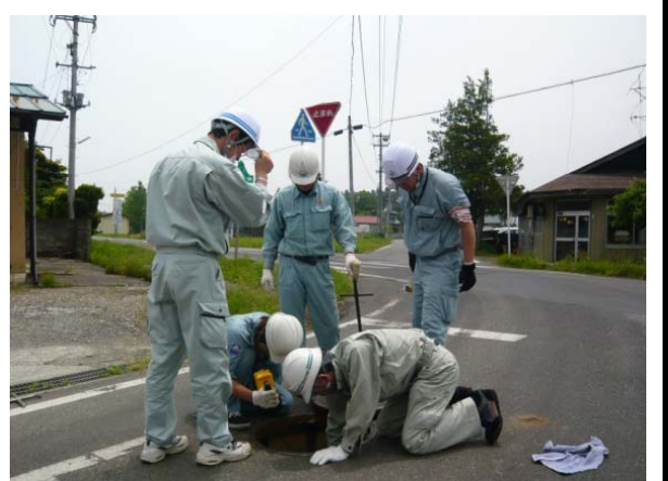
菅きよ・マンホール全量目視調査状況(1)
