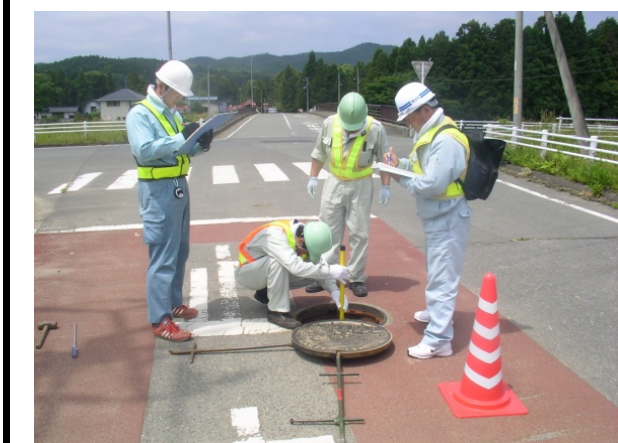
菅きよ・マンホール全量目視調査状況(2)
