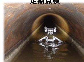
テレビカメラによる管路調査
