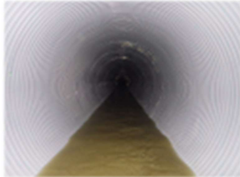
腐食した既設管路の内面を被覆
