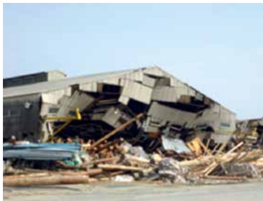
写真 合板工場の被災状況 [建屋の倒壊]
