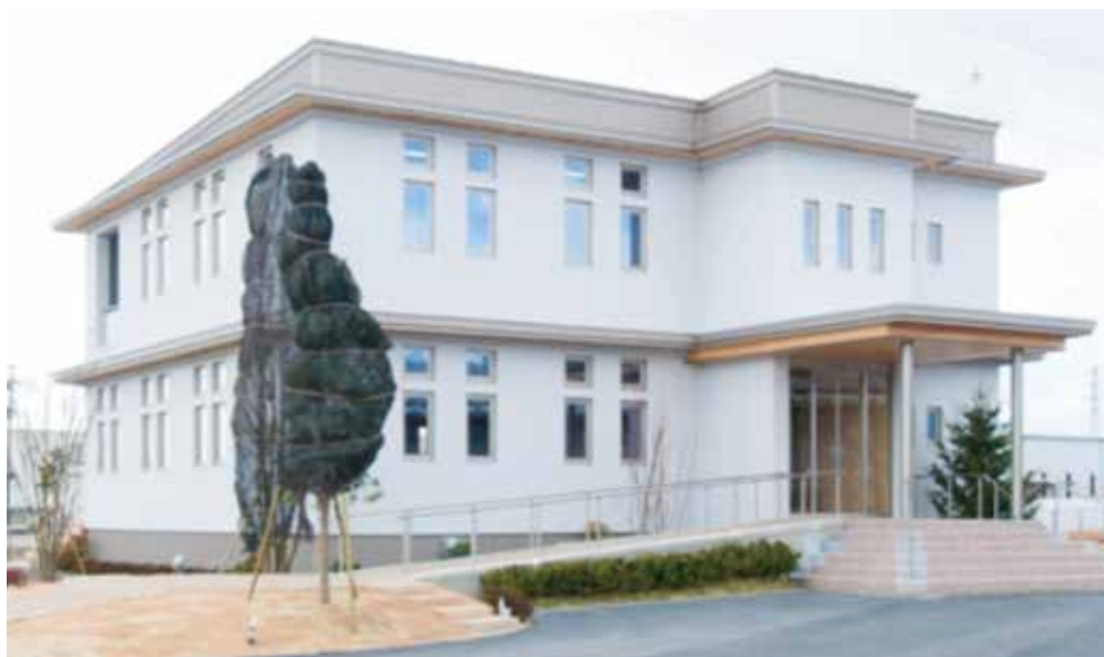
写真 モデル施工② ナイス株式会社仙台物流センター事務所棟（写真提供／ナイス株式会社） 施工主体：すてきナイスグループ株式会社 構造：木造（CLT工法）+RC造<混構造：日本初> 規模：2階建 延床面積：約360㎡ 平成29年3月完成<林野庁補助活用>
