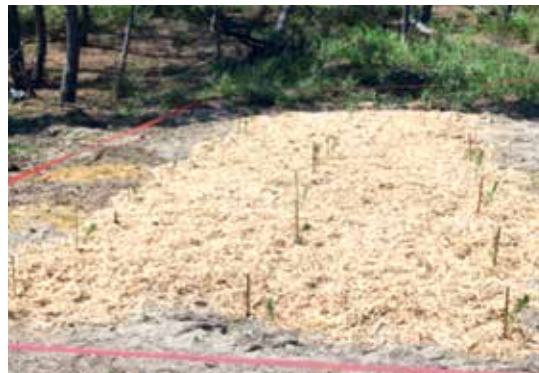
写真 砂の移動を抑止するためのマルチング施工
