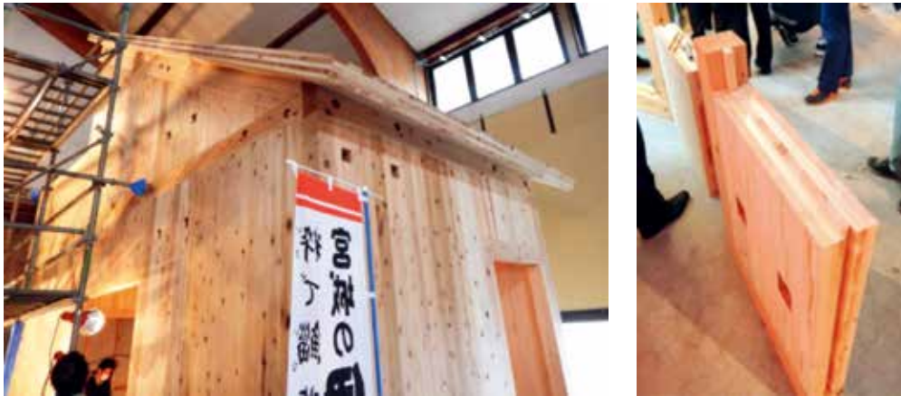
写真 CLTの試作② (株)山大、(株)ミヤウッド、石巻合板工業(株)、石巻地区森林組合の取組<林野庁補助活用> 躯体モデル施工：在来軸組工法+CLT（屋根・床・壁）
