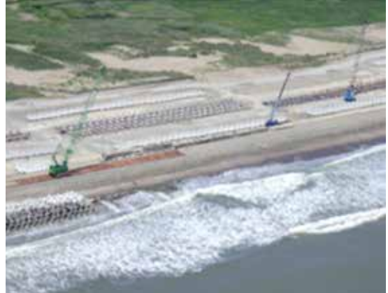
写真 大曲浜（東松島市）における消波ブロックの設置
