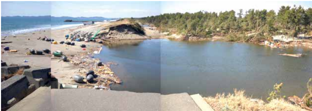
写真 大曲浜（東松島市）の防潮堤被災状況
