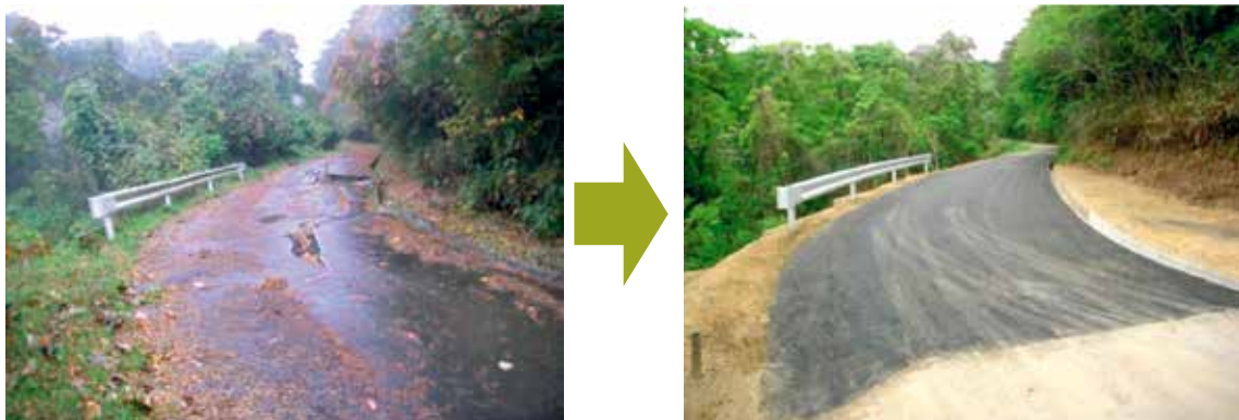
写真 大崎市 小坂山線（左：被災状況 右：復旧状況）
