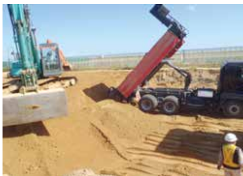
写真 植生基盤盛土工施工状況 (巨理町)
