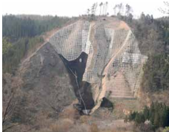
写真 長峯（白石市）の復旧治山工事（H27）
