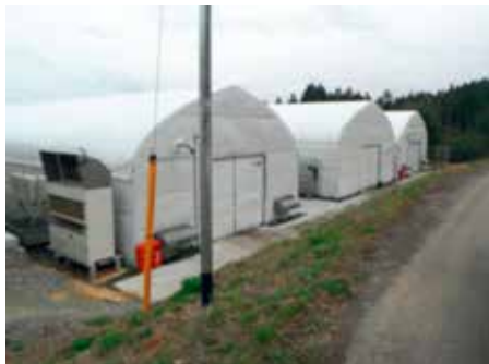
写真 津波で被災した施設の復旧
