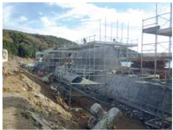
写真 十八成（石巻市）におけるコンクリート打設
