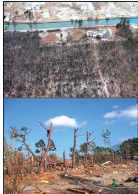
写真 海岸防災林の被災状況 (上：仙台市若林区、下：気仙沼市)
