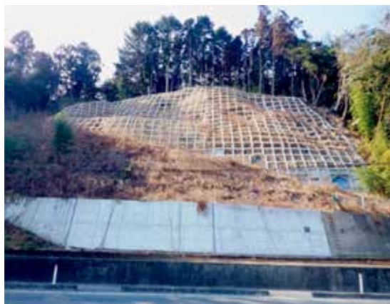
写真 上沢目（東松島市）の復旧治山工事（H26）
