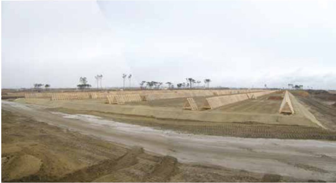
写真 植生基盤盛土、防風工完了状況（仙台市）
