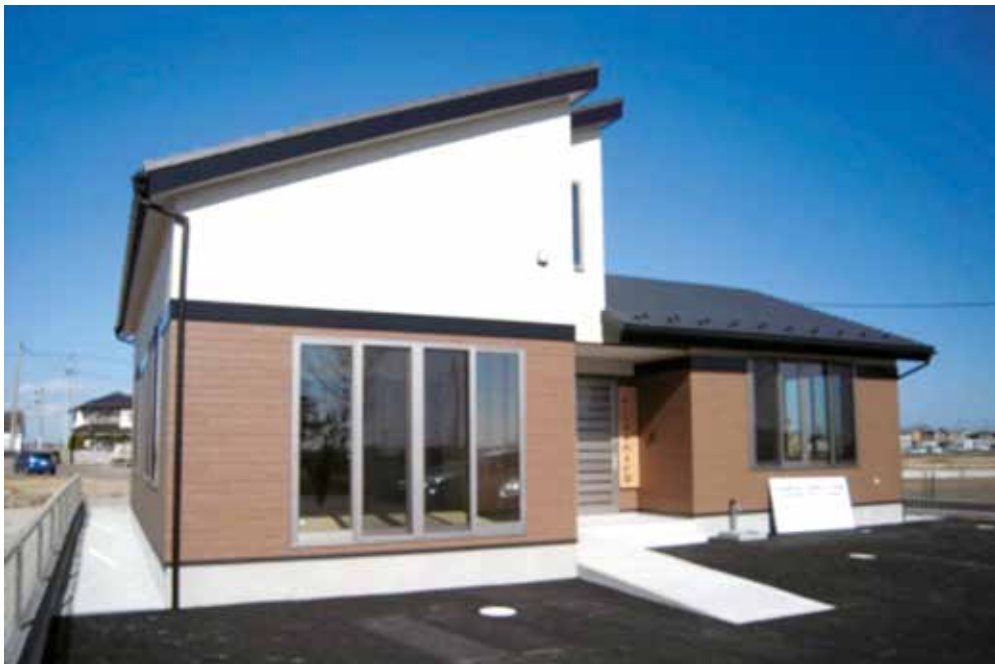
写真 モデル施工① みんなの木材資料館兼（仮設）名取市関上公民館（名取市） 施工主体：一般社団法人宮城県建築士事務所協会 モデル施工：在来軸組工法+CLT（屋根・床・壁） 規模：2階建 延床面積：約129㎡ 平成28年3月完成 <林野庁補助活用>
