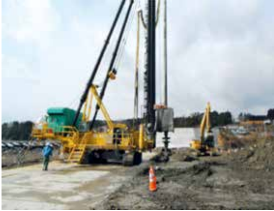
写真 長須賀（南三陸町）における地盤改良
