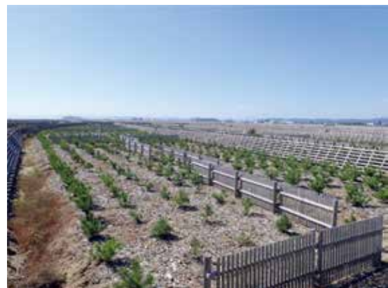
写真 完成状況（名取市）
