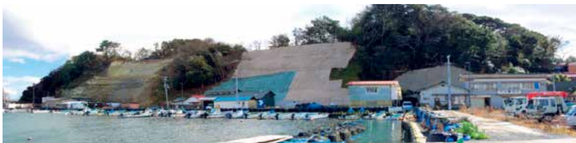
写真 桂島（塩竈市）の施工状況（H27）
