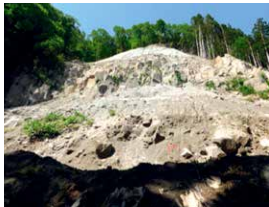
写真 中道（大崎市）の被災状況
