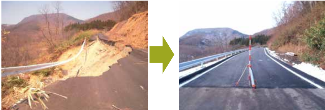
写真 大和町 高倉線（左：被災状況 右：復旧状況）
