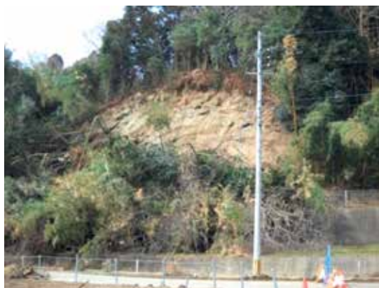
写真 上沢目（東松島市）の被災状況
