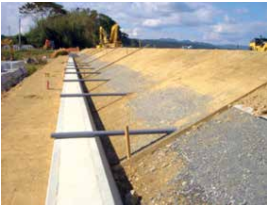
写真 波伝谷（南三陸町）における堤体盛土
