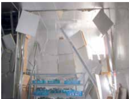
写真 地震により損傷したきのこ生産施設
