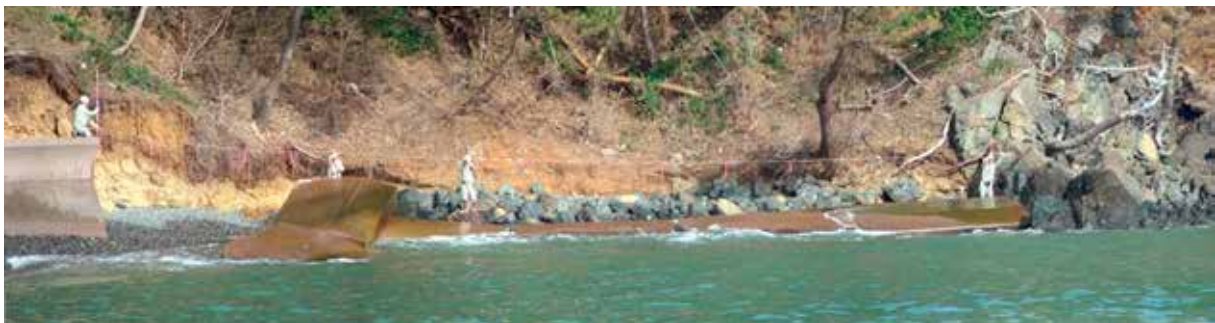
写真 温浜（気仙沼市）の防潮護岸被災状況
