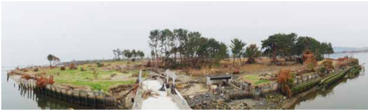
写真 蛭塚（巨理町）の防潮護岸被災状況
