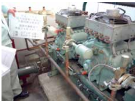
写真 地震の震動により電気系統が損傷した空調機器の修繕
