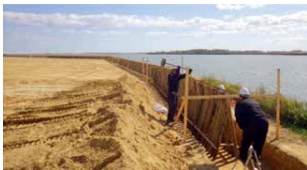
写真 防風柵施工状況 (巨理町蛭塚)
