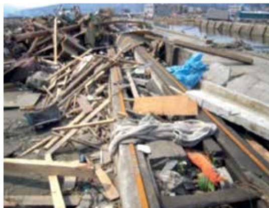
写真 製材工場の被災状況 [施設全損：中央は製材機のレール]
