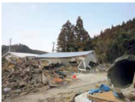
写真 津波により被災したきのこ生産施設
