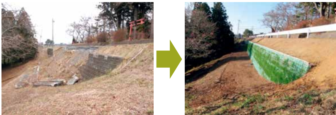
写真 南三陸町 小屋の沢~蕨野線（左：被災状況 右：復旧状況）
