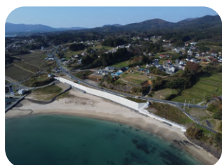
防潮堤の整備 (日門漁港海岸) 施工中
