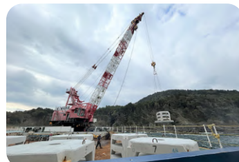
藻類着定基質の設置工事
