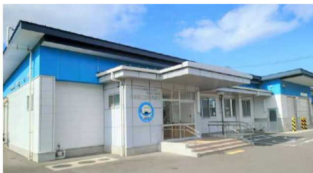
水産加工公開実験棟
