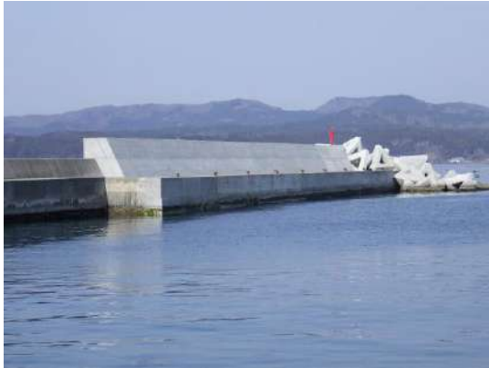
機能強化事業 泊（歌津）漁港（泊防波堤）
