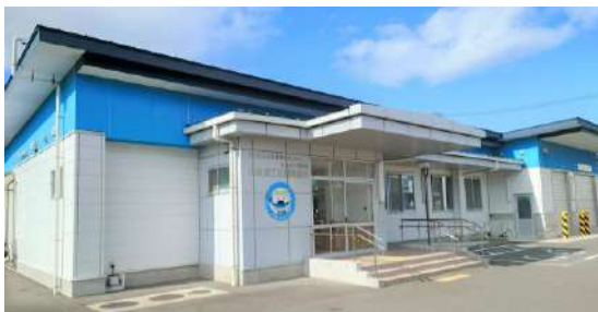
水産加工公開実験棟（石巻市）
