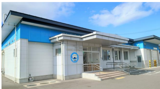
水産加工公開実験棟
