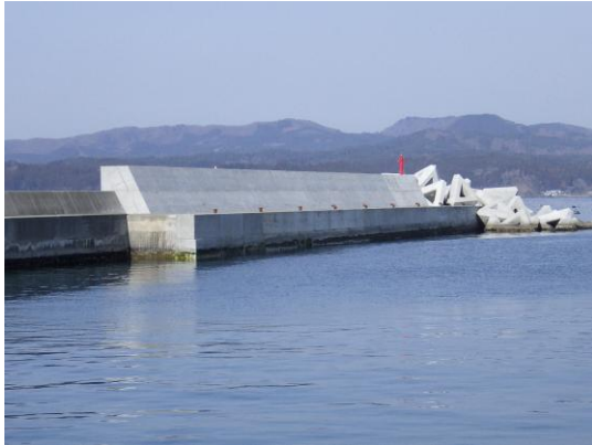
機能強化事業 泊（歌津）漁港（泊防波堤）
