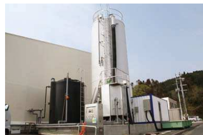
魚市場に整備されたスラリーアイス製氷機(ヤマト福祉財団の支援)
