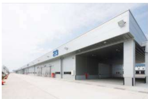
石巻漁港 石巻魚市場東棟
