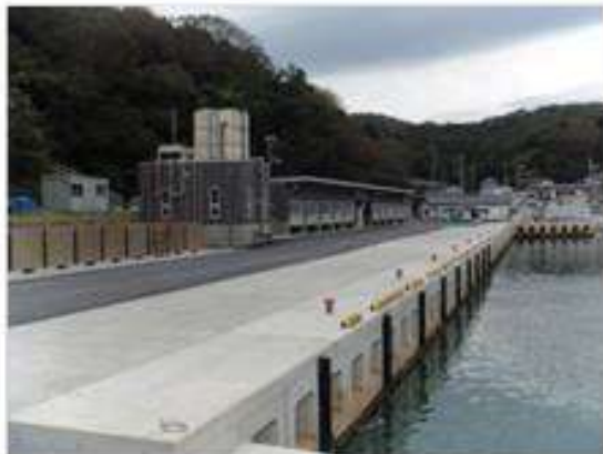
狐崎漁港 -2.0m 物揚場
