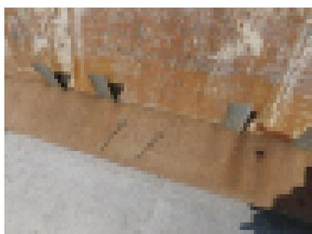
図 4.1.4 ウエザーシールのはずれ
