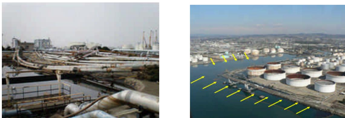
図 5.1.8 津波により湾曲した配管及びオイルフェンス展張状況
