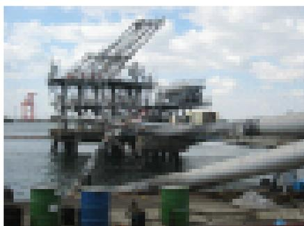
図 5.1.14 津波による LPG タンカー棧橋の破損
