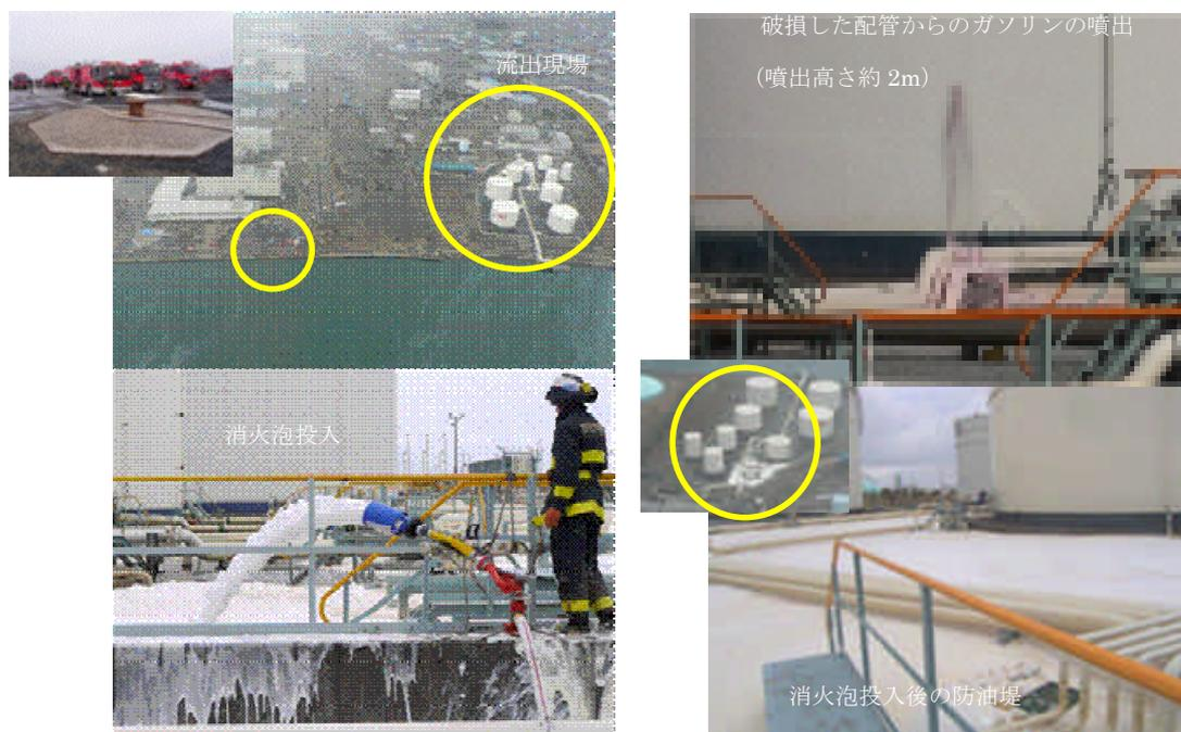
図 5.1.1 仙台地区の事業所における屋外タンク貯蔵所附属配管の破損及び危険物流出事故
