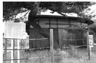
震災で被災の山元町文化財復旧着手 大條家茶室魅力知って
