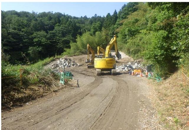
写真: 擁壁撤去・埋戻状況
