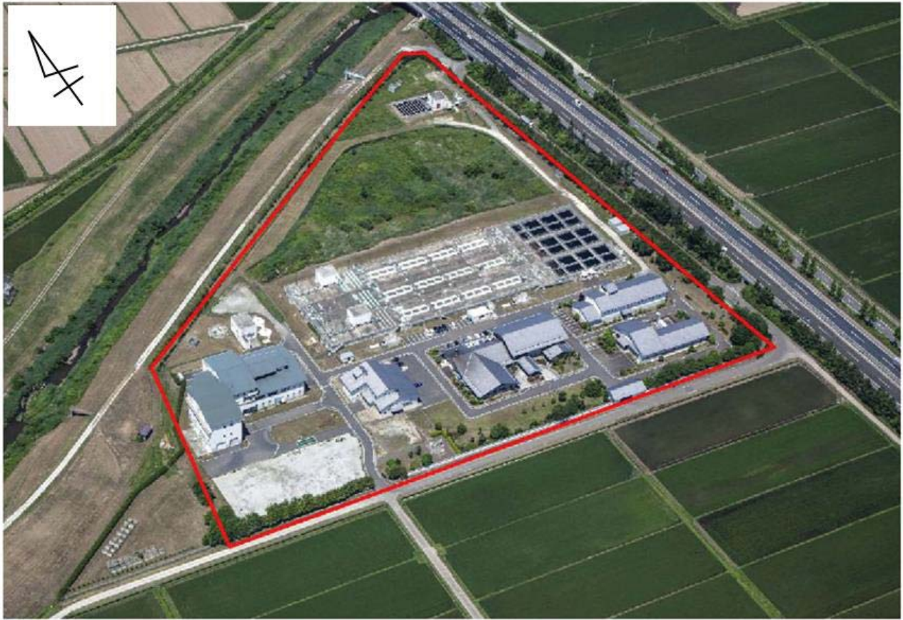
大和浄化センター全景図（赤線部分が敷地）
