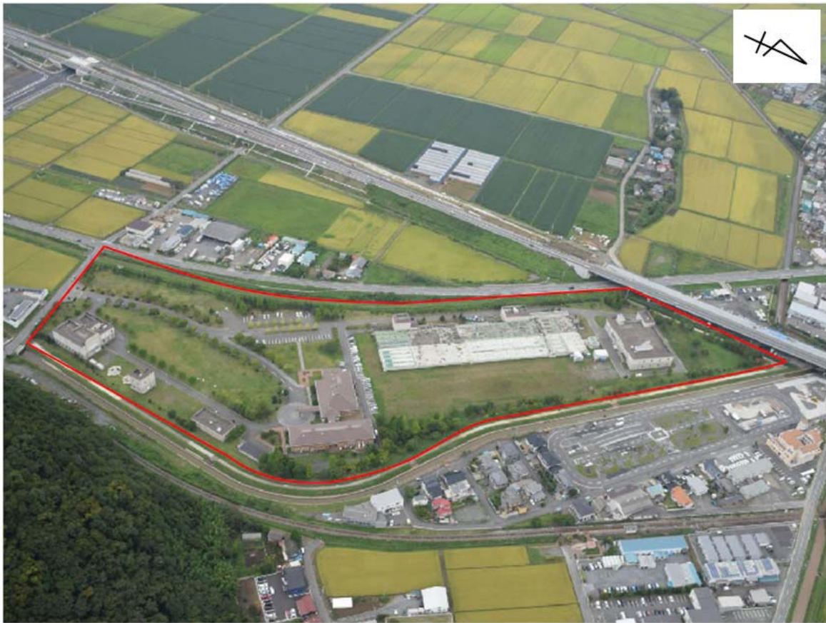
石巻浄化センター全景（赤線部が敷地）
