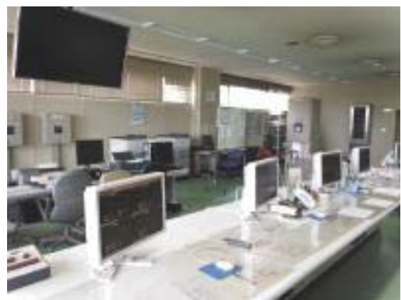
(中央監視制御装置)
