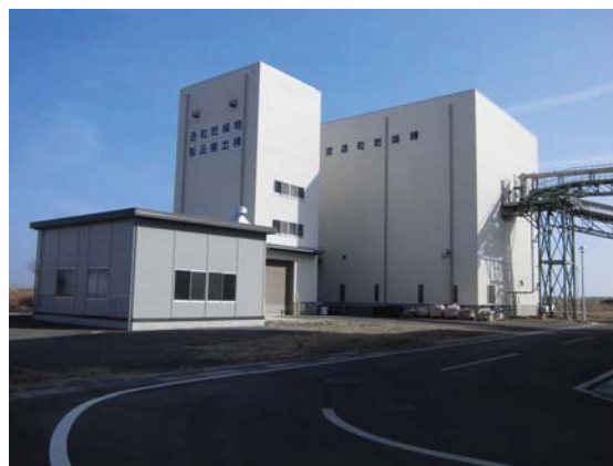
(汚泥燃料化施設)
