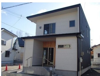
入居が始まった伊保石地区災害公営住宅
