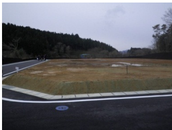
造成工事が完了した藤浜団地
