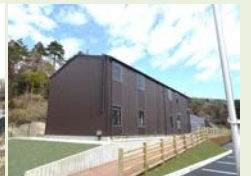
③ 農林水産業体験施設(熱源等供給施設)
