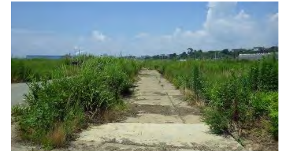
暗渠化されていた聖人堀
