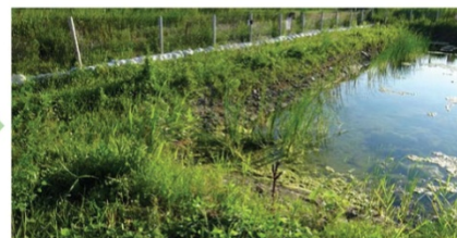
法面植生や藻類の繁茂 (2016.07.29)
