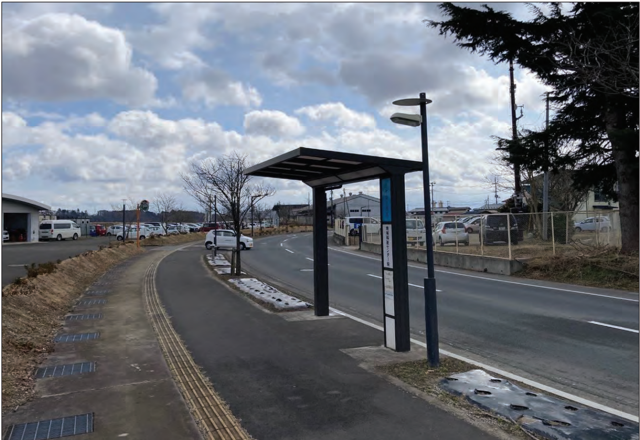
バス停 施工後
