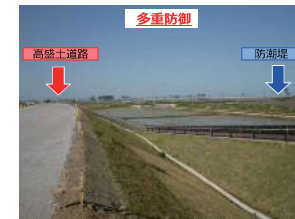
(例)仙台市若林区井土地区(令和元年5月撮影)
