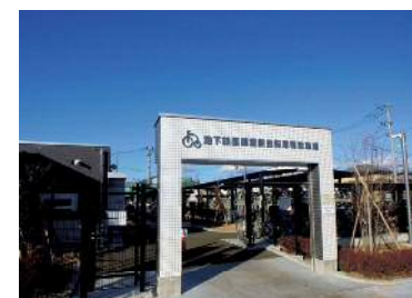
自転車駐車場（薬師堂駅自転車駐車場-仙台市）
