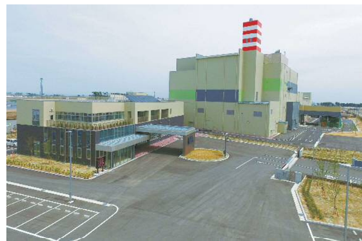
ごみ焼却場（巨理名取共立衛生処理組合ごみ焼却場-岩沼市）
