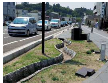
広告物景観モデル地区 （塩竈市北浜沢乙線沿線地区（塩竈市））
