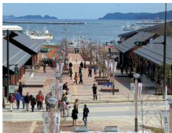
一団地の津波防災拠点市街地形成施設 (女川浜地区一団地の津波防災拠点市街地形成施設－女川町)
