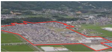
(例)山元町新山下駅周辺地区(平成30年7月完了後撮影)
