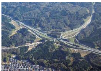
自動車専用道路（仙台北幹線－富谷市）
