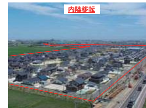
(例)岩沼市玉浦西地区(平成27年7月完了後撮影)
