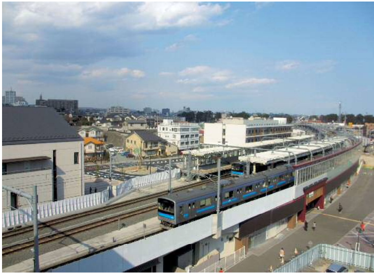
仙石線多賀城地区連続立体交差事業（多賀城市）
