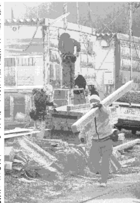
仮設住宅の防寒工事。災害公営住宅の完成を待つ入居者も多い。平成23年12月21日、石巻市
