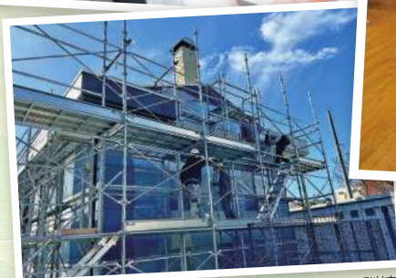
足場の組立て訓練
