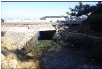
【盆ノ沢橋梁長寿命化】
