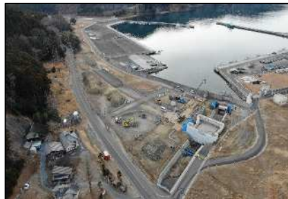
【②（主）石巻鮎川線・風越Ⅲ】
