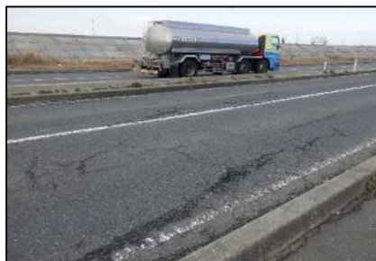
【(一) 石巻港インター線・舗装補修】
