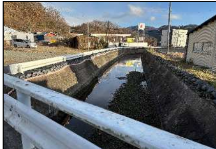
【②大沢川河川改修事業】
