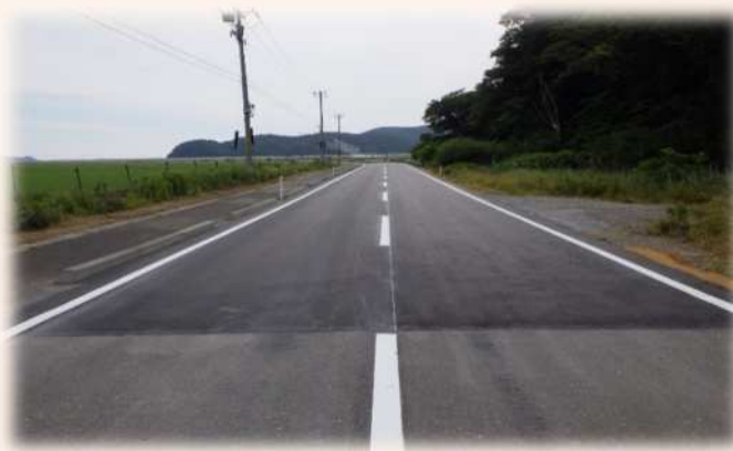
釜谷舗装補修工事【令和6年5月完成】
