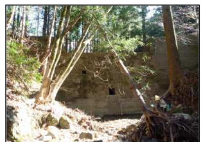
【芦早堰堤砂防メンテナンス】
