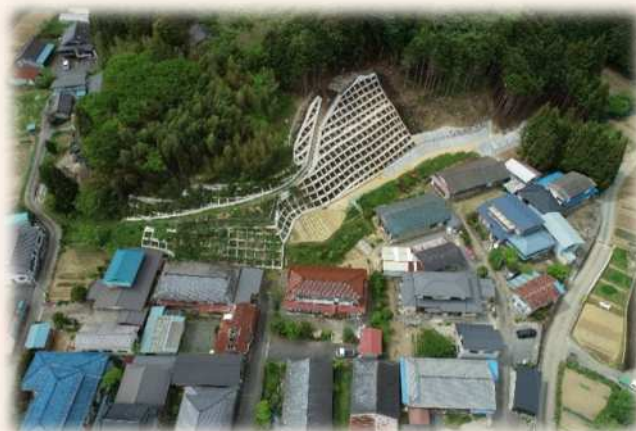
崎山の2急傾斜地工事【令和6年5月完成】
