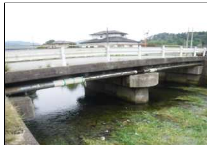
【(主) 北上津山線・大沢橋架替】
