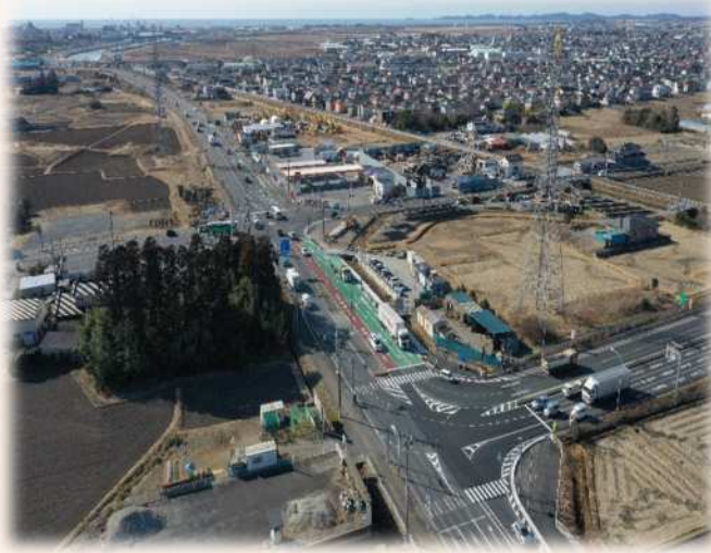
赤井南三交差点改良【令和7年3月完成】
