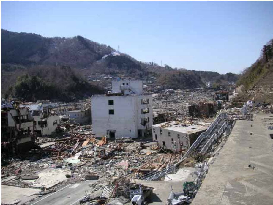
倒壊した建物で覆われた国道398号(女川町内)
