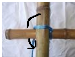
④下の竹の下方からロープを通し上の竹に平行にかける。
