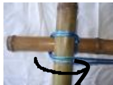
①下の竹にロープの輪の方を通す。
