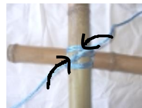
④下の竹の下方からロープを通し上の竹に平行にかける。
