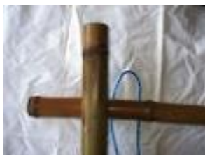
①下の竹にロープの輪の方を通す。
