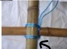
⑤元の位置に戻ったら上下の竹の間をロープで強く締める。
